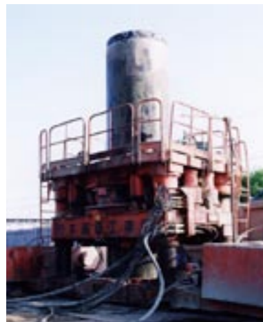
1 スーパートップ機セット及び杭芯確認後掘削開始。
