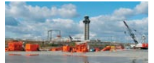
アメリカ、アトランタ空港での施工風景
