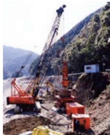
2 ケーシングを全周回転して地盤に切削。圧入ハンマーグラブで掘削、排土。
