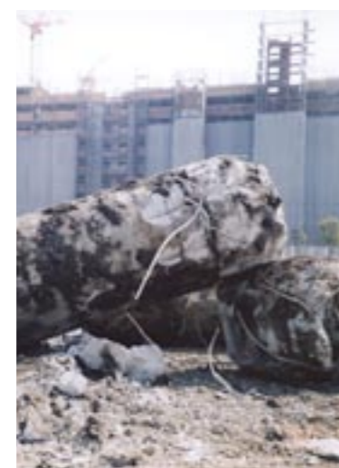
月掘り出された場所打ち杭
