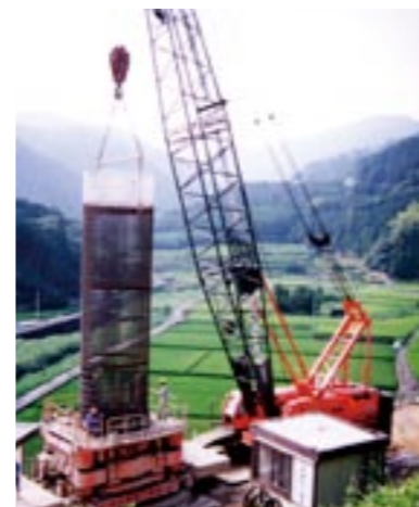
4 掘削完了後、鉄筋カゴ挿入。
