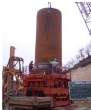
3 ケーシング継ぎ足し。
