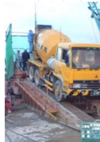
6 トレミー管を引抜きつつ生コン打設。
