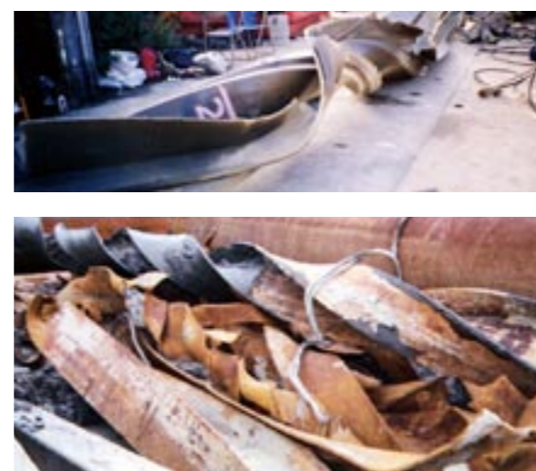
火掘り出された鋼杭
